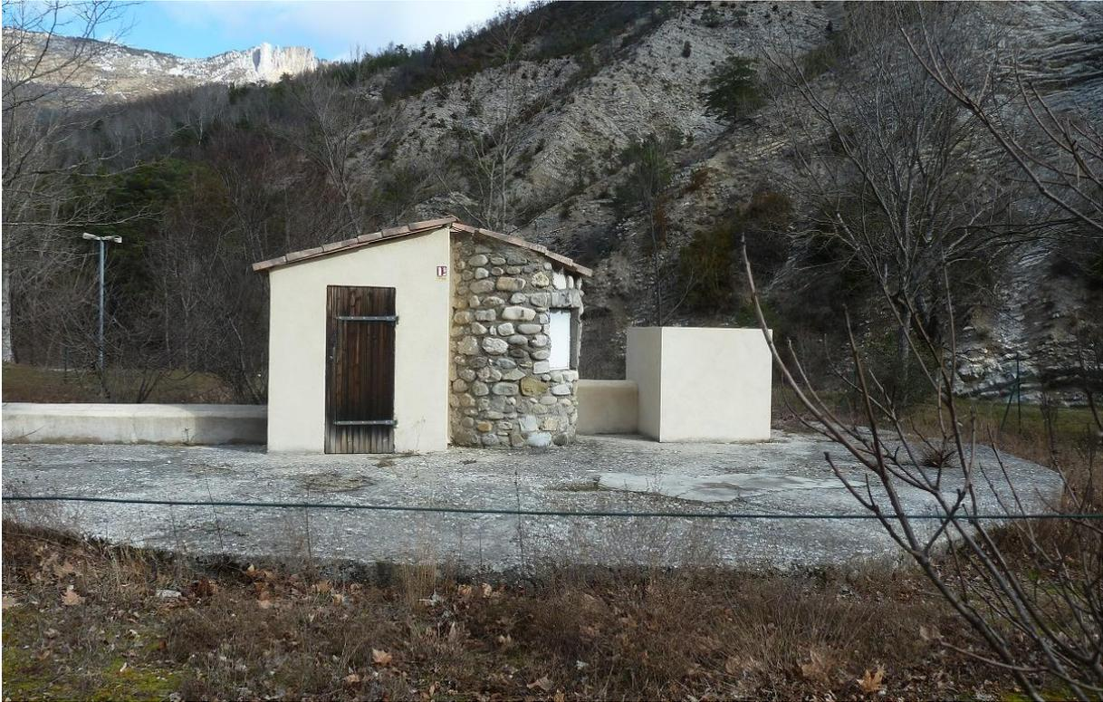
Le puits réalisé par havage est busé sur 8m de profondeur. Pour des raisons techniques, il n'a pas été possible de poursuivre l'ouvrage et seule la dernière buse béton est perforée. Dans ce contexte, ses performances sont limitées. Il n'est plus utilisé pour l'AEP mais dispose d'une petite pompe de surface avec une prise de secours pour l'incendie.
